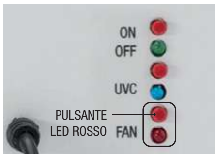
Foto 2: con il terzo tasto in basso si può modificare la velocità delle ventole, dal 100% al 50%, funzionamento al 50%, il Led rosso è acceso.
