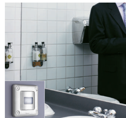
SANITÁRIO PÚBLICO | Detetor de movimentos
